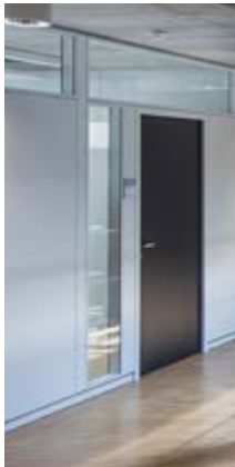
Oberlichter und Glaselemente neben den Türen schicken viel Tageslicht ins Gebäude
